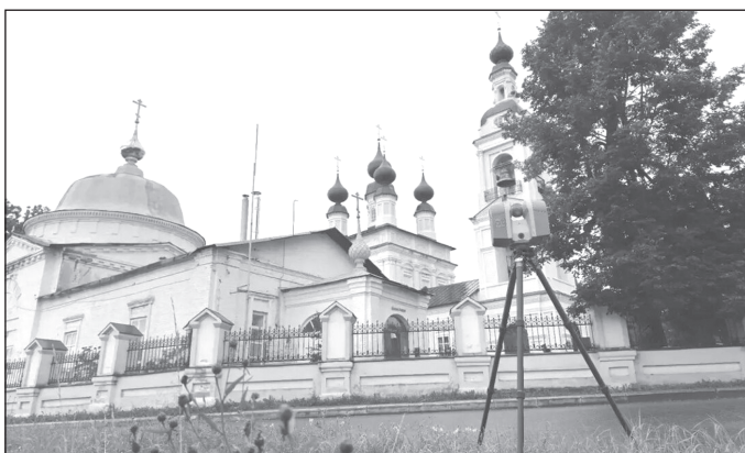
Также идёт подготовка проектной документации для реставрации памятника федерального значения Ильинская церковь на Соборной горе
