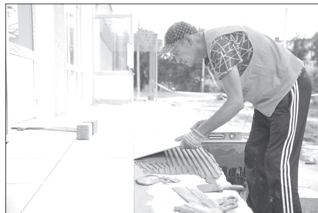
Строительство новой поликлиники в Авдотьино - на завершающем этапе. Фото: Д. Рыжаков
