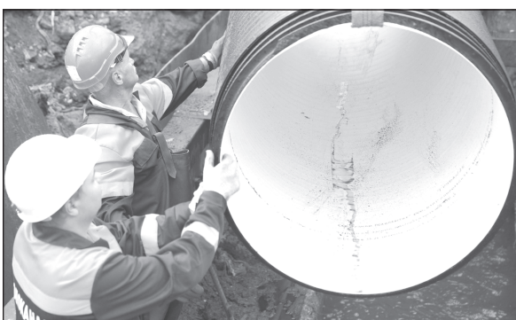
Идет проверка работ по капремонту канализационного коллектора. Фото Д. Рыжакова
