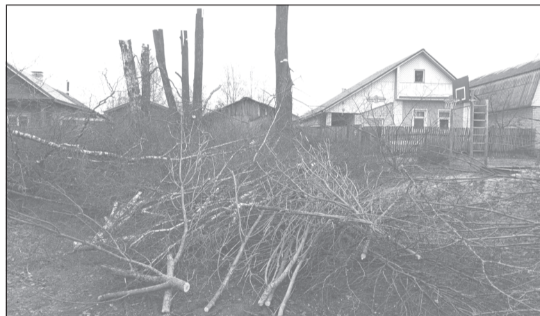
Идёт выпилка аварийных деревьев по наказам избирателей
