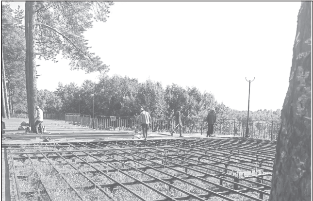
С площадки открывается прекрасный обзор окрестности, но кусты в овраге необходимо вырубить
