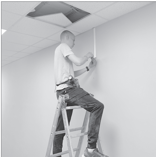
Строители занимаются отделочными работами в кабинетах и на этажах
