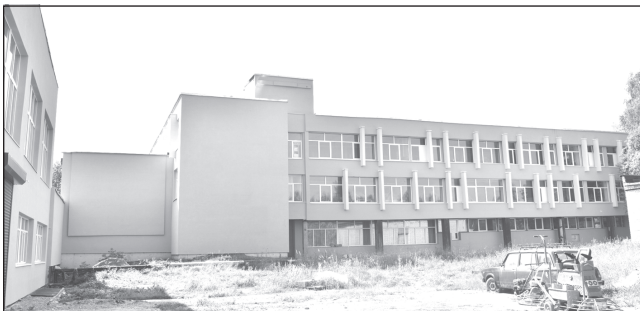
Здание колледжа давно нуждается в капитальном ремонте
