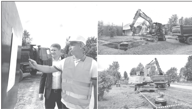
Строим новые водопроводы в сельской местности
